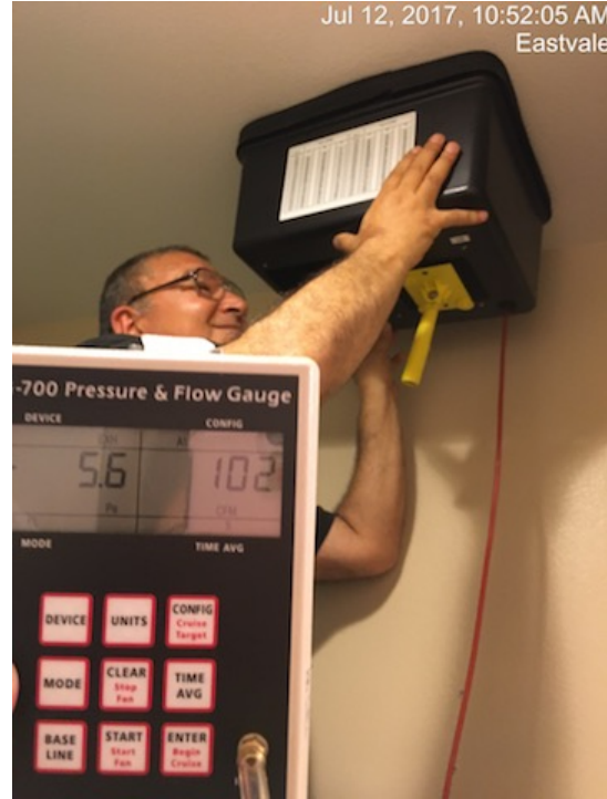
Exhaust Fan Airflow
